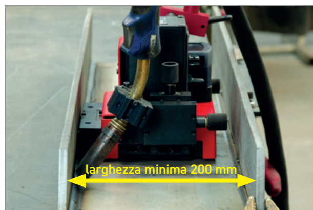
Saldatura in spazi ristretti
